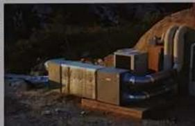
Les pompes à chaleur sont généralement utilisées pour extraire la chaleur contenue dans le sol (ou dans l'air) et alimenter un réseau de chauffage. Les pompes à chaleur fonctionnent électriquement.
