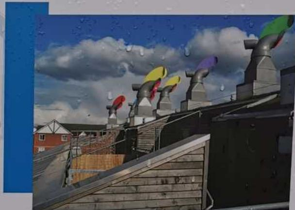
Les conduits d'air décoratifs et fonctionnels témoignent de l'originalité du **système de ventilation naturelle passive avec récupération de chaleur** des immeubles du quartier BedZED (Royaume-Uni). Le vent pénètre dans les appartements par des conduits et expulse naturellement l'air humide des cuisines et des salles de bains à l'extérieur par d'autres tunnels d'aération. Concernant l'**isolation des logements** de BedZED, les murs d'une épaisseur de 30 cm sont particulièrement efficaces.
