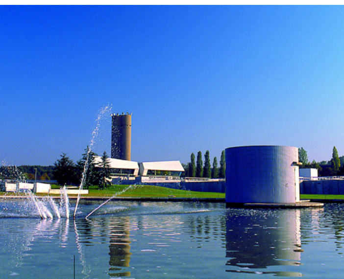
L'usine de traitement de l'eau de Morsang-sur-Seine.
